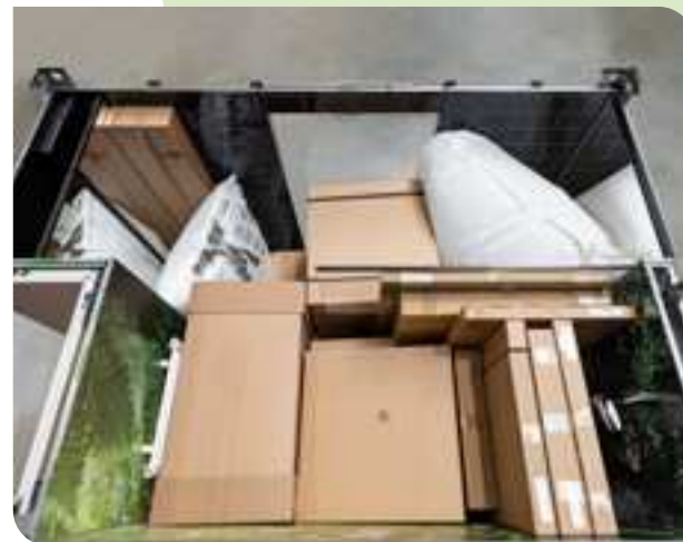
optimierter Bauprozess durch Teillieferung der Möbel in den Fertignasszellen
